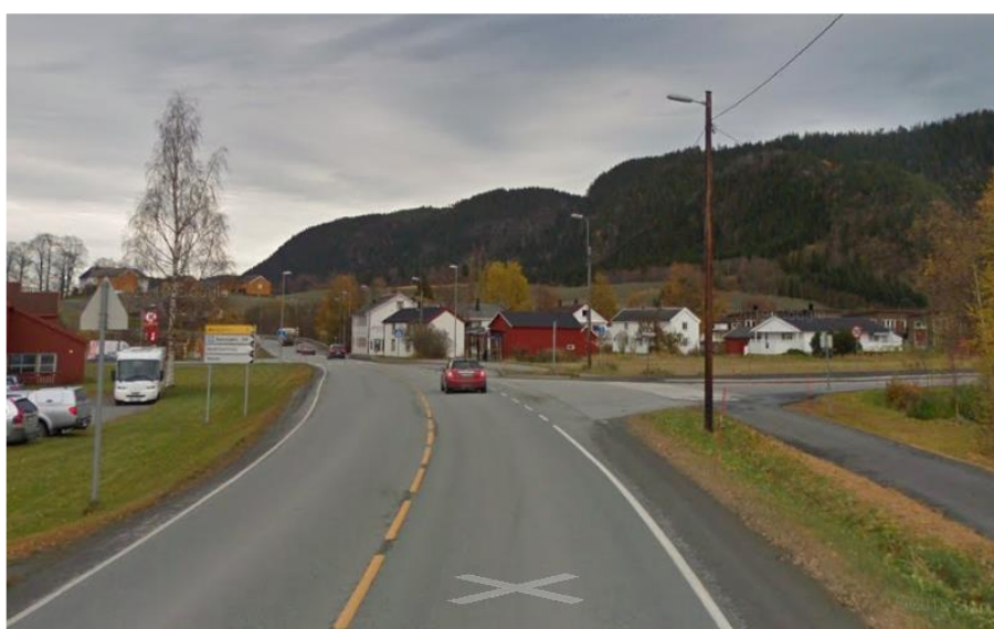
Figur 4: E6 mot nord, kryss Lundadalsvegen til høyre i bildet
